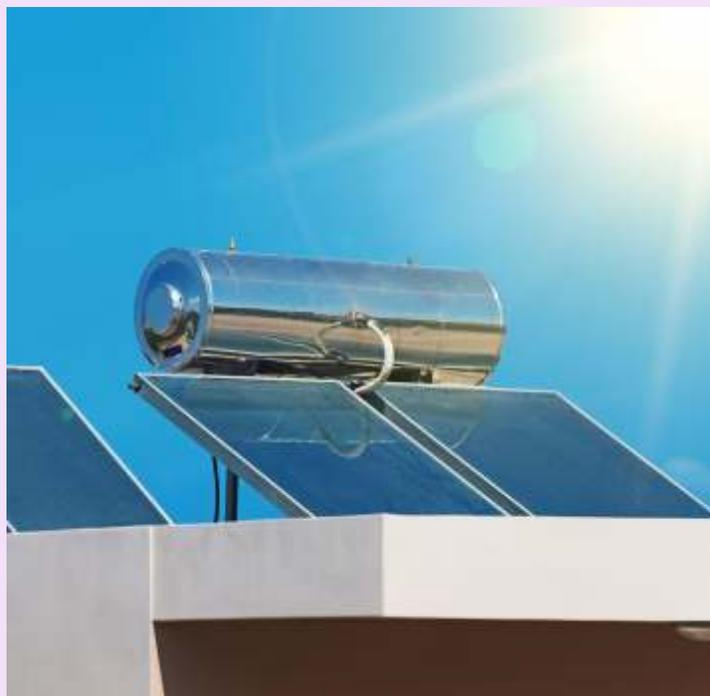
Los colectores solares para calentar agua suelen ser paneles negros montados en el tejado o una serie de tubos colectores negros. Estos dispositivos contienen materiales que absorben el calor y lo
