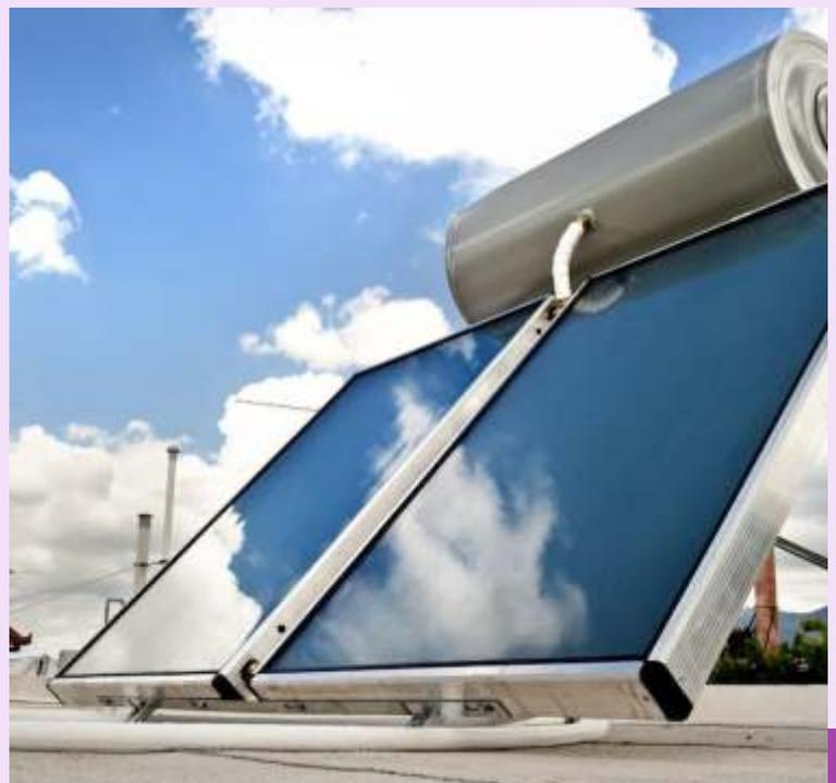
Los colectores solares también pueden configurarse como una serie de tubos colectores negros, que actúan en general de la misma manera: tanto los paneles como los tubos tienen materiales que absorben el calor y lo conducen al suministro de agua. A menudo, como en la foto, el calentador de agua está unido a paneles en el tejado para reducir la pérdida de calor y maximizar la presión del agua. Los calentadores de agua solares también pueden utilizarse para calentar piscinas.
