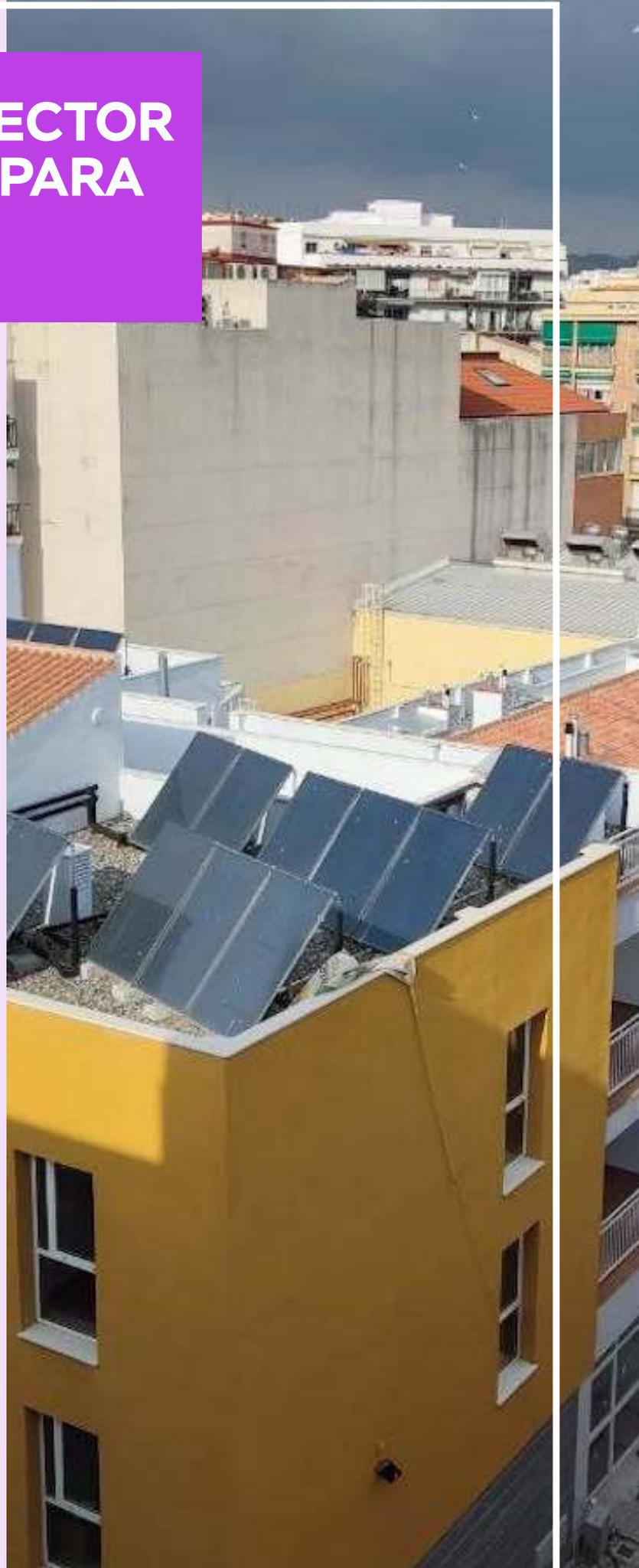
Los colectores solares pueden ser no concentrados o concentradores. La diferencia entre ellos es que los colectores de concentración tienen un interceptor más grande que el absorbedor, mientras que los colectores de no concentración tienen ambos con el mismo tamaño. Los colectores solares planos y de tubo de vacío se utilizan para fines domésticos, como calefacción, agua caliente o refrigeración.
