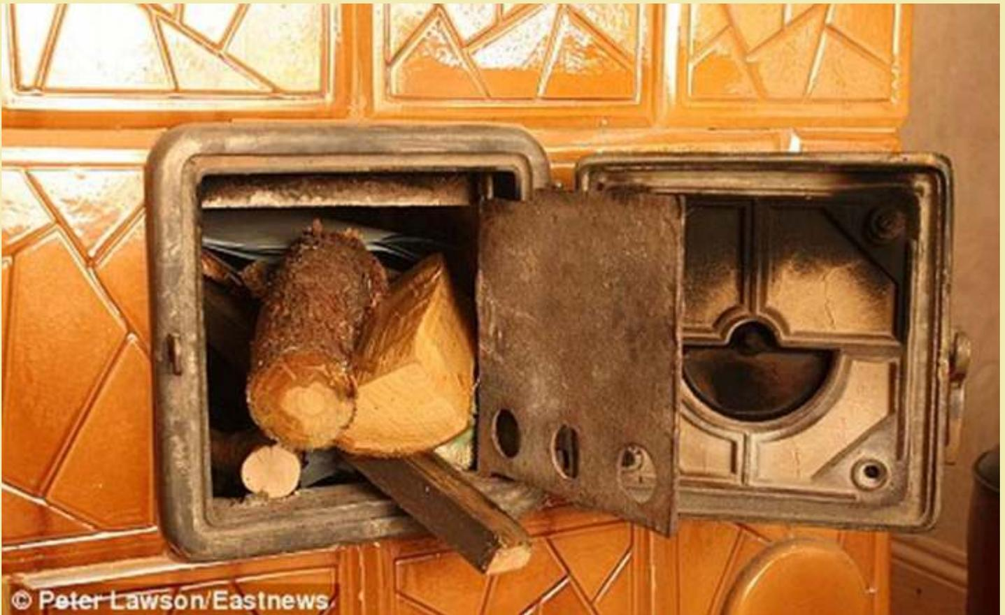
su interior que se calienta y radia calor a través de los azulejos. Te mantiene caliente durante unas 12 horas. Además, tiene una pequeña estufa donde puedes hornear patatas y otras cosas en una de las trampillas.»
